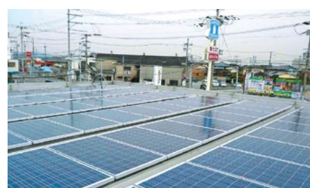
約2,000店舗の屋根に太陽光発電設備を設置。さらに再生エネルギー導入を強化
